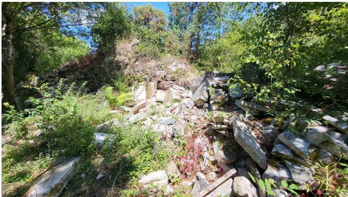
Figura 33. Outra escombreira ao nordeste do sector
